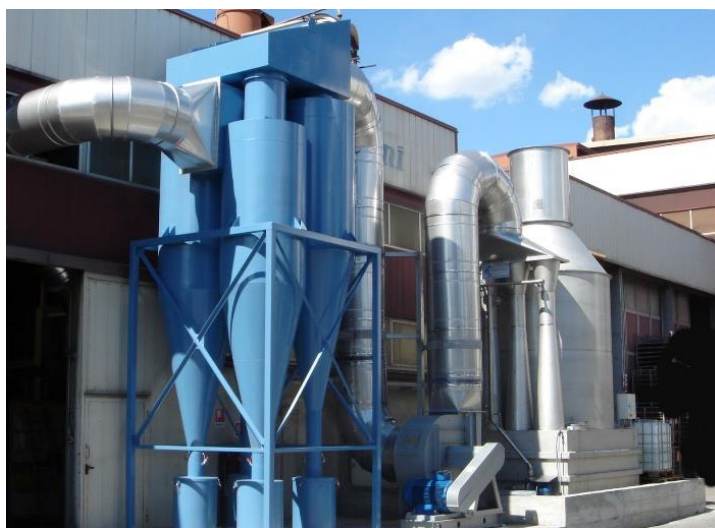
Figura 11. - Venturi scrubber in ACCIAIO INOX con cicloni di pre-abbattimento polveri a monte.
