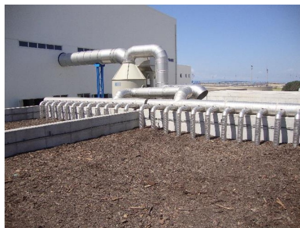
Figure 14. / 15. - Particolari del sistema di aereazione nel biofiltro.
