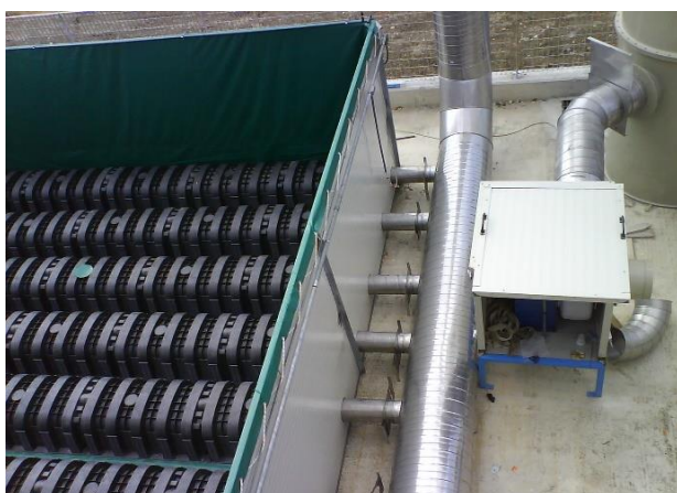
Figure 14. / 15. - Particolari del sistema di aereazione nel biofiltro.
