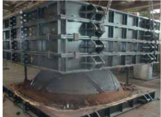
Attrezzatura di colata / Equipment of casting.
