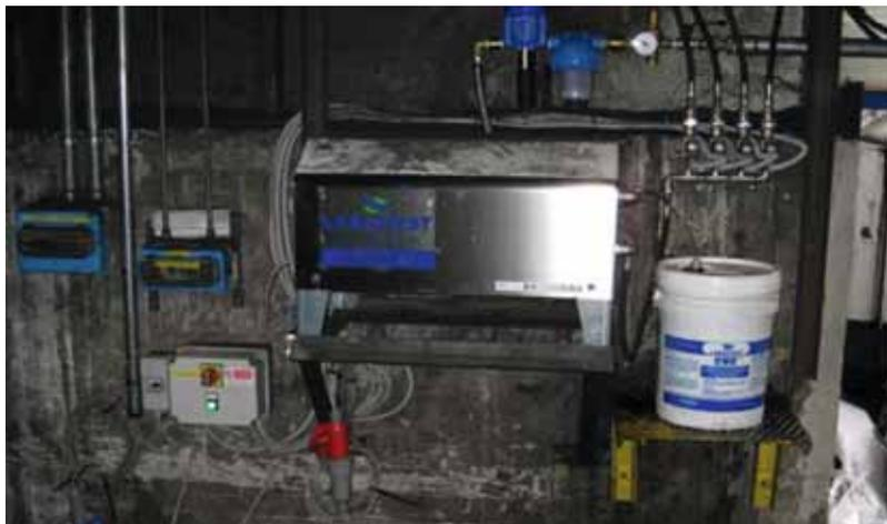
■ Fig. 3 - Sistema di nebulizzazione installato, sistema di regolazione e di fornitura prodotto.
