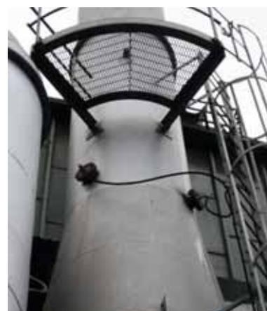
Fig. 2 - Sistema di nebulizzazione installato, vista del camino.
