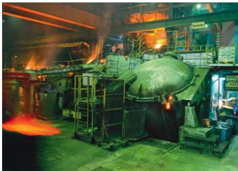
■ Con un esperimento alla fonderia Gienanth a Eisenberg, Germania, Linde Gas ha confrontato l'efficienza tipi diversi di bruciatori utilizzati per il riscaldamento delle siviere ed il mantenimento in temperatura operativa (foto e grafica: Linde Gas).
