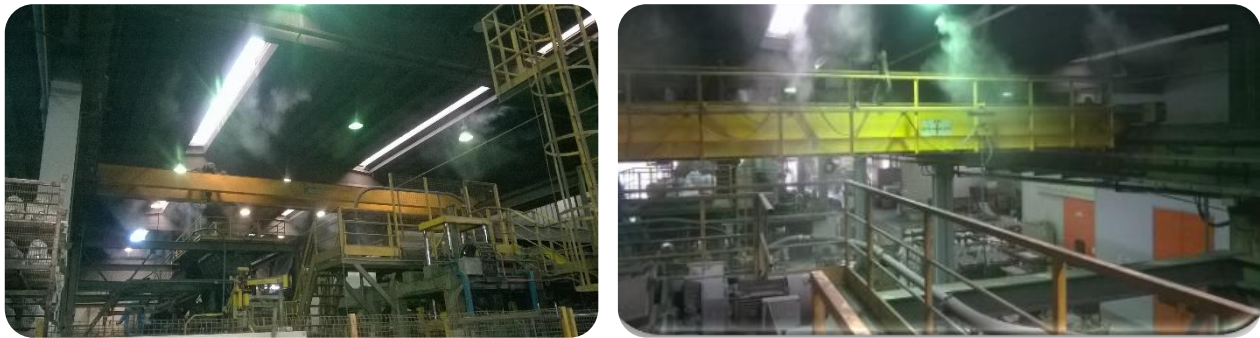
Figure 16. -17. Utilizzo di sistemi di nebulizzazione di prodotti osmogenici in fonderia.
