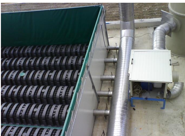
Figure 12. - 13. Particolari del sistema di aerazione nel biofiltro.
